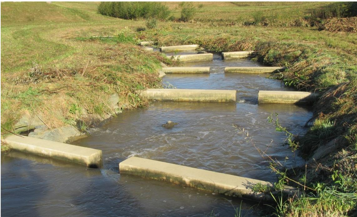
Abbildung 18: Naturnaher Beckenpass oberhalb der Einmündung des Grieselbaches. Foto: W. Lazowski
